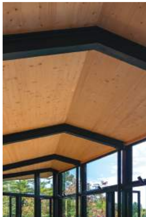
使用三层交错层压木板并进行折叠，形成完整结构。
