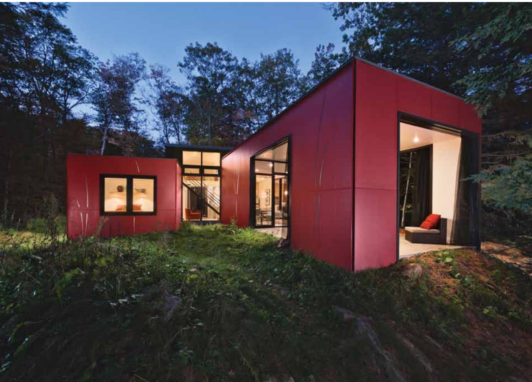
↑ בית נופש המיועד למיפלט אורבני, לזוג אספני אמנות ובתם, מצא מקומו ביער
